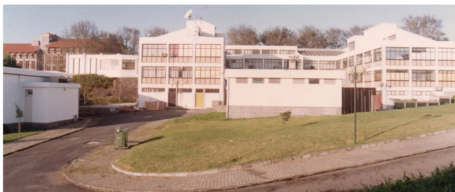
Fachada posterior dos departamentos de Biologia e de Geociências década de 70/90
