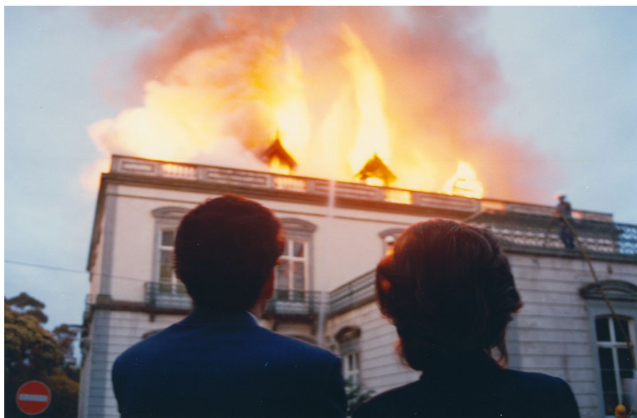
Incêndio ocorrido no edifício da Reitoria da UAc a 12 de junho de 1989
