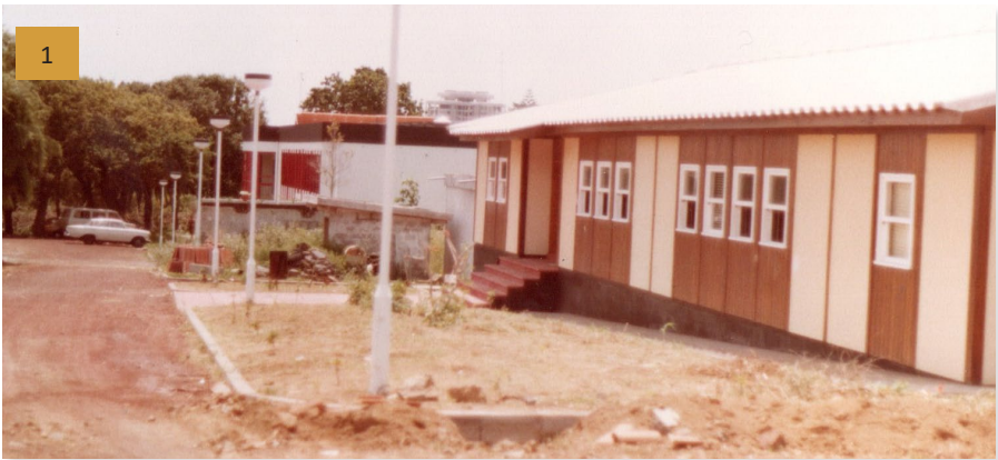
1 Construção da Biblioteca
